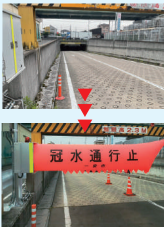
現地での冠水表示の様子
